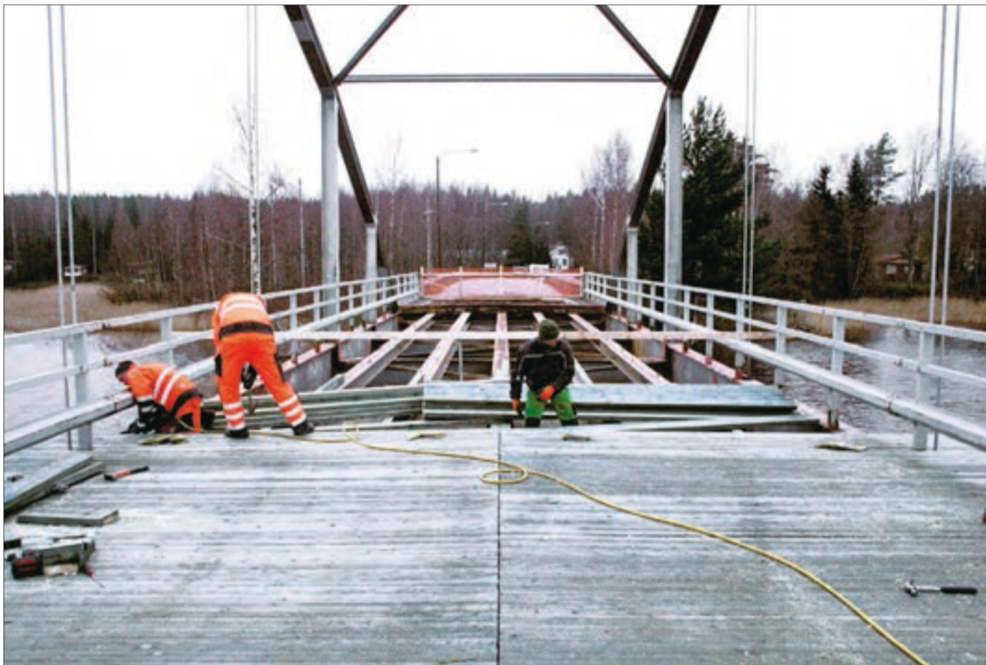
Reparationerna av Hellnäs bro beräknas ha kostat 150 000 euro. Men nu ska den hålla i flera decennier framåt.
