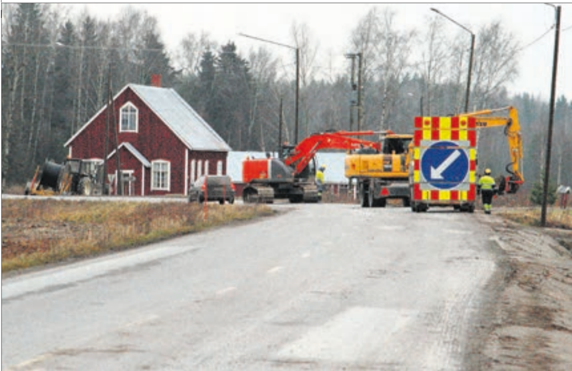
Under hösten har fiberkabeln grävts ned längs vägen mellan Oravais och Vörå. För ett par veckor sedan var grävmaskinerna i Karvsor. FOTO: KARIN SUNDSTRÖM
